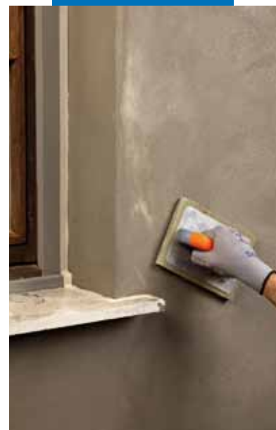
Frattazzatura di Planitop 210
