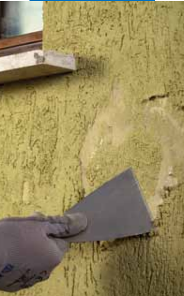
Rimozione del rivestimento plastico non aderente
